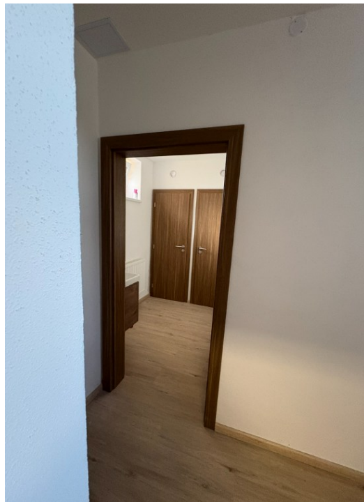
Rekonstrukce sociálního zařízení na OÚ
