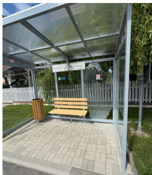
Čekárna na ulici Drážní
